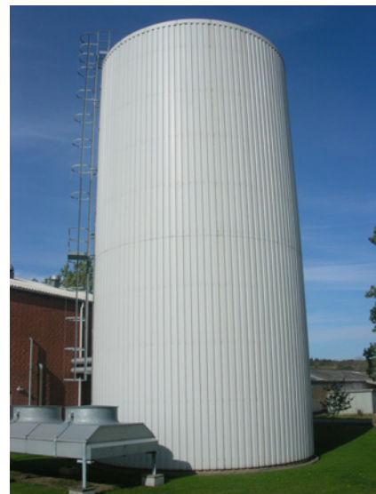
Abbildung 4.2: Große thermische Speicher
